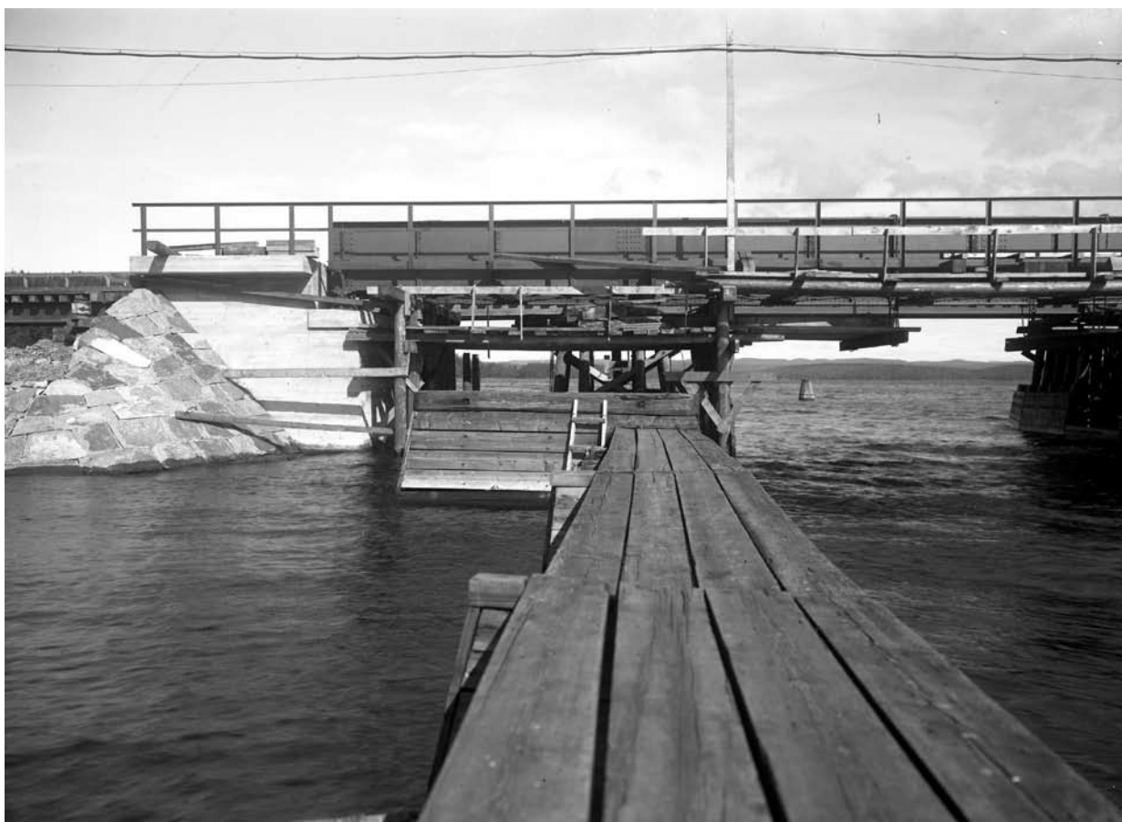
Den nya bron är på plats och det provisoriska spåret är borttaget. Fotot taget 1936.
