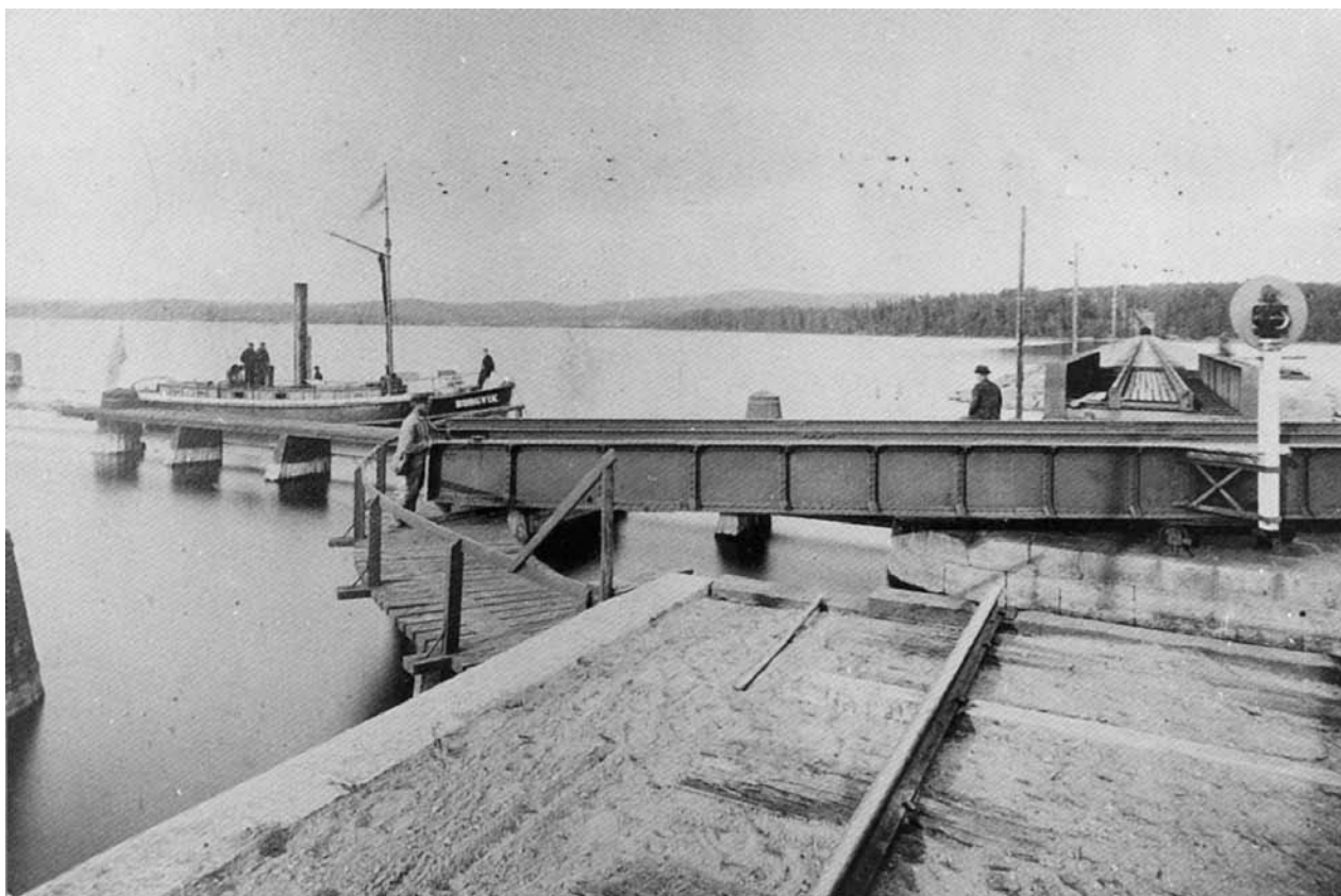
Den gamla svängbron öppnas för bogserbåten Borgvik.
