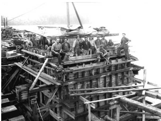
Formsättning inför gjutningen av de nya brofundamenten,
