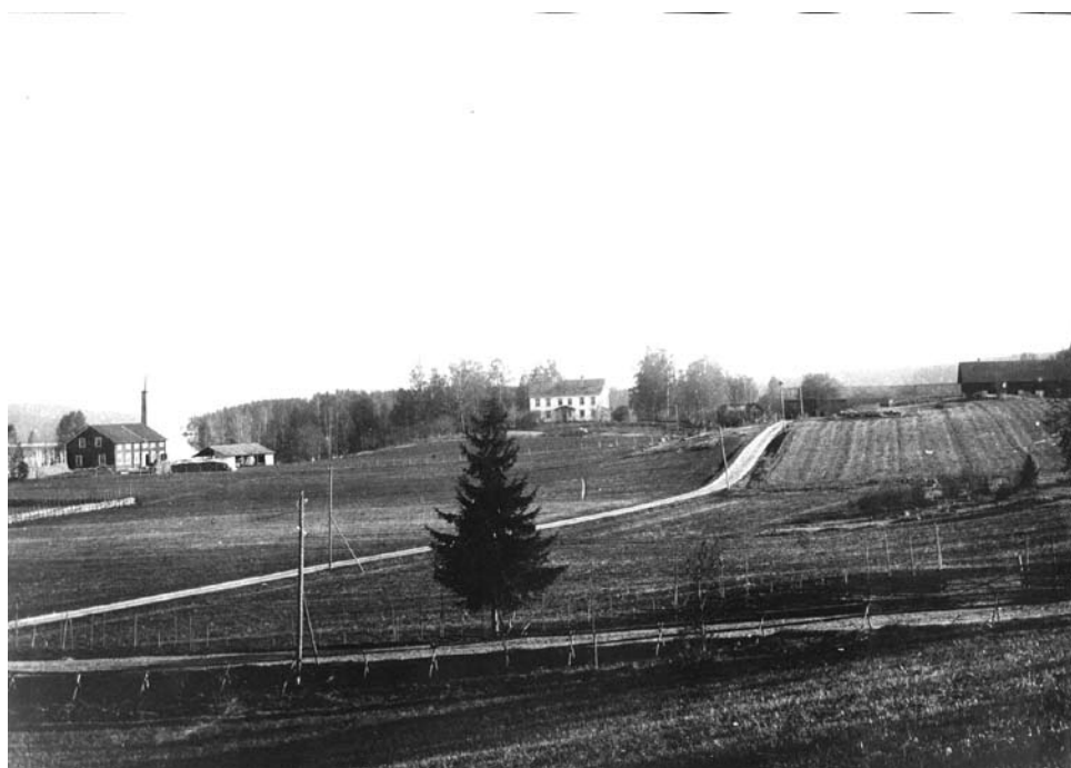
Foto av Årnäs Herrgård och Sjöviks snickerifabrik. Målningen är troligen gjord med fotot som förlaga.
